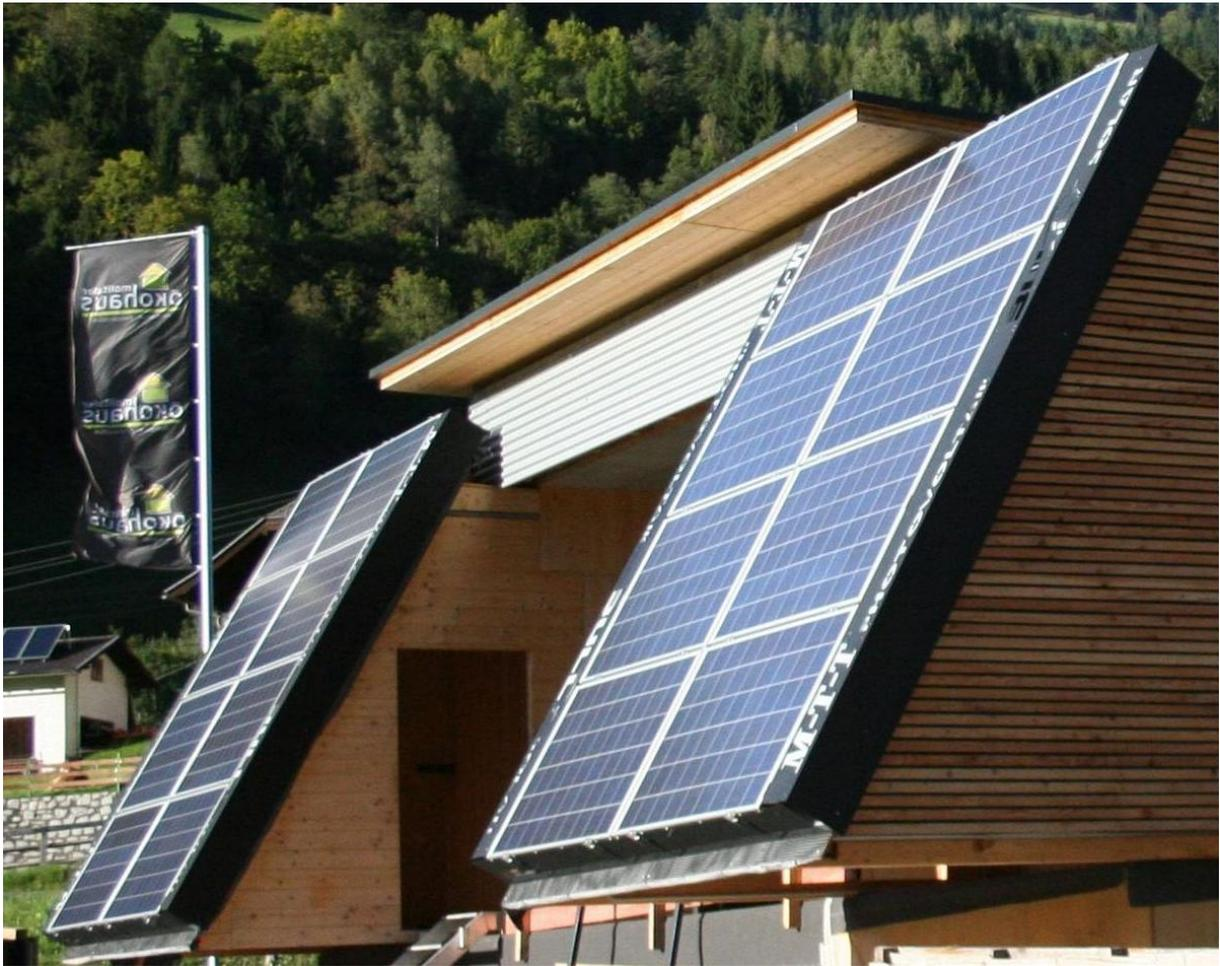
Die desolaten Dachziegel sollten auf der Südfront durch Photovoltaik ersetzt werden.
